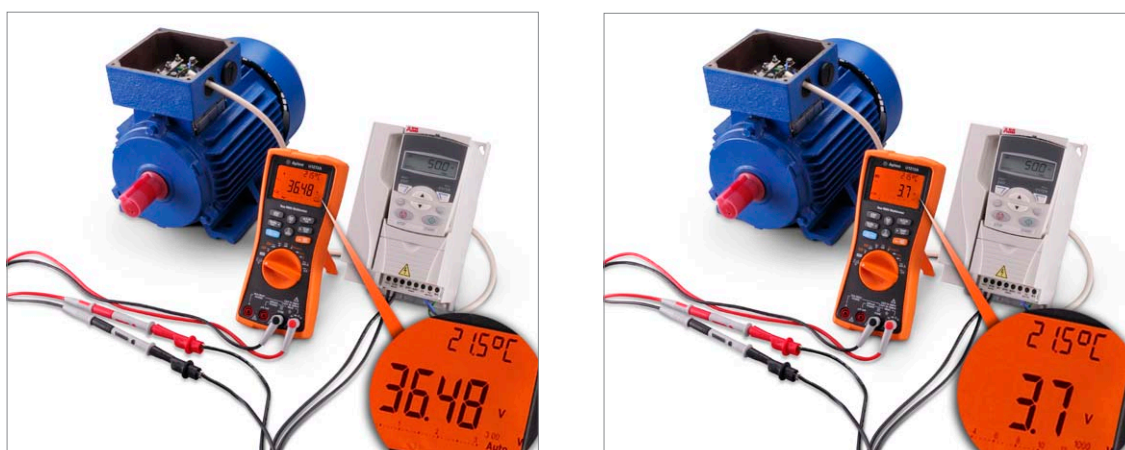
図1：U1272Aでは、産業用モータのVFDに電源を供給する配線と平行して非接続状態の配線がある場合は、この配線で浮遊電圧が発生しているかどうかを確認できます。右の図は、低入力インピーダンス・モードでの測定値（浮遊電圧成分を含まない）です。
