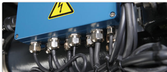
プラント制御 PLANT CONTROL
