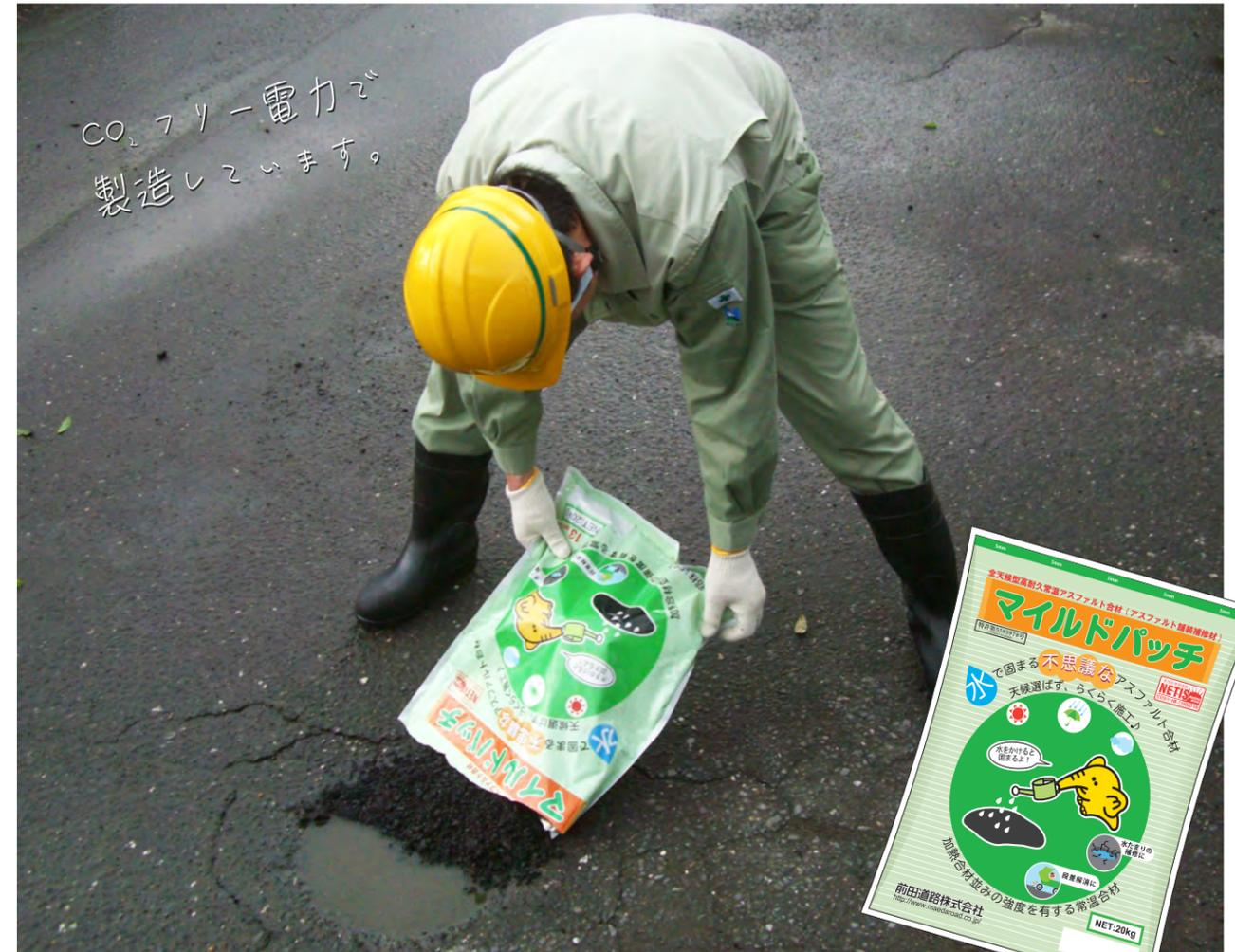
「マイルドパッチ」は、水をかけて、踏み固めるだけで固まる新しいタイプの袋詰め常温合材です。
