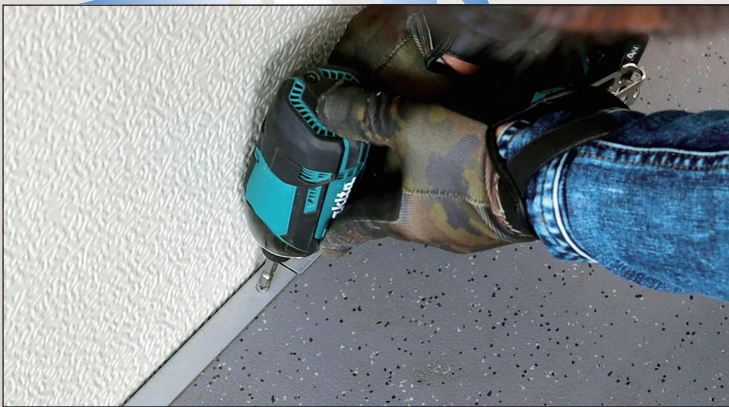
インパクトドライバの頭が邪魔で 作業がしにくい
