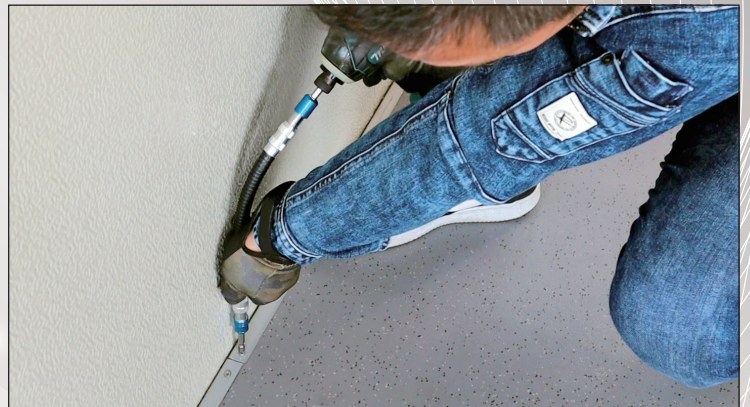
フレキシブルW ソケット双龍を使用 作業がしやすい
