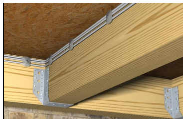
例 ケーブルの取付け
