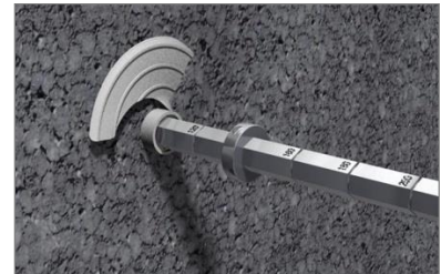
例：EPS 断熱材ボード内へ termoz SV-II ecotwist の施工
