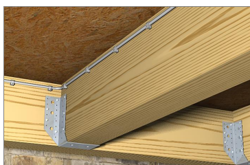
例 ケーブルの取付け
