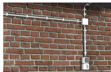
例 ケーブルの取付け
