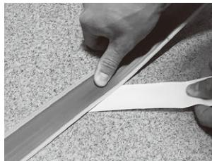
③ 曲線部はRタイプをご使用ください。直線部分を10cm程確保してから、徐々にけがき線などの目印に沿わせて貼り付けてください。
