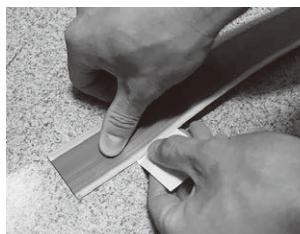
② たわみが生じないようピンと張った状態で、剥離紙を剥がしつつ、押しながら貼り付けてください。
