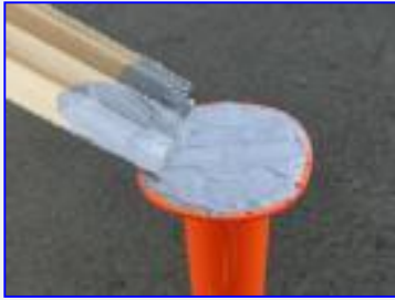
⑨ 攪拌棒を板状に開き、凹み部をロードボンドで満たし、表面をならす
