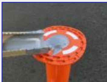
⑧ 被着体に適量のロードボンドをのせる
