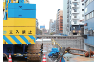
屋内外の建築土木
