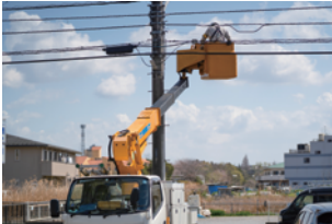
炎天下の高所作業
