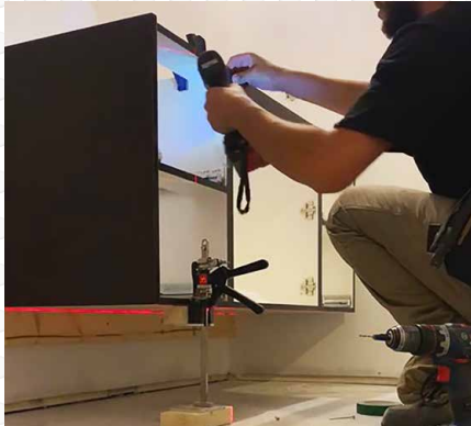
棚やキャビネット、空調設備等の設置固定やレベル調整が簡単に出来ます。
