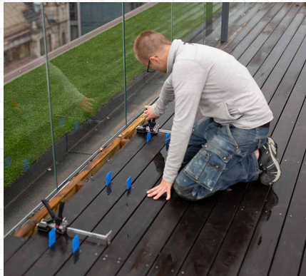
ウッドデッキ施工などに。
