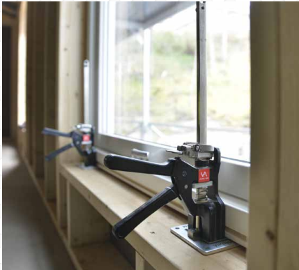
窓や窓枠、梁などの設置に。
