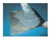
へこみ箇所の補修時は、補修部へ埋め込むように 塗布した後、少し多めに肉盛りしたほうが、後の 作業がやりやすくなります。
