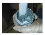
硬化剤投入後、2~3分程度ツヤガなくなるまで十分に混合攪拌します。
