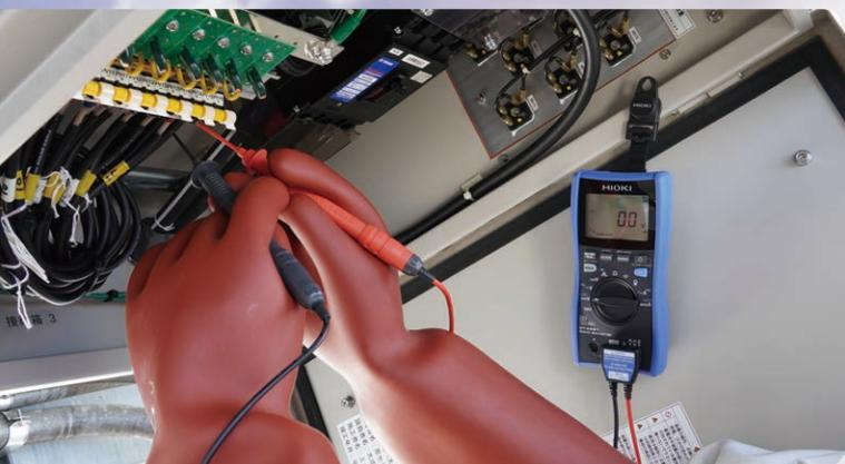
1500 Vの太陽光発電設備が普及する中、より高い電圧に対応できる測定器の需要が高まっています。今後、さらに設備の高電圧化が進むことを想定し、HIOKIはCAT III 2000 Vの規格に適合した直流高電圧プローブP2010を開発しました。高い安全性に加え、使いやすい形状による快適な測定操作が可能です。現在、そして将来の高電圧ニーズに対応するP2010は、進化する太陽光発電設備の電圧測定に最適です。
