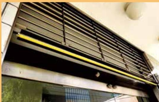
長さ自由なテープ状スイッチで、指先で軽く押せばどこでも作動します。
